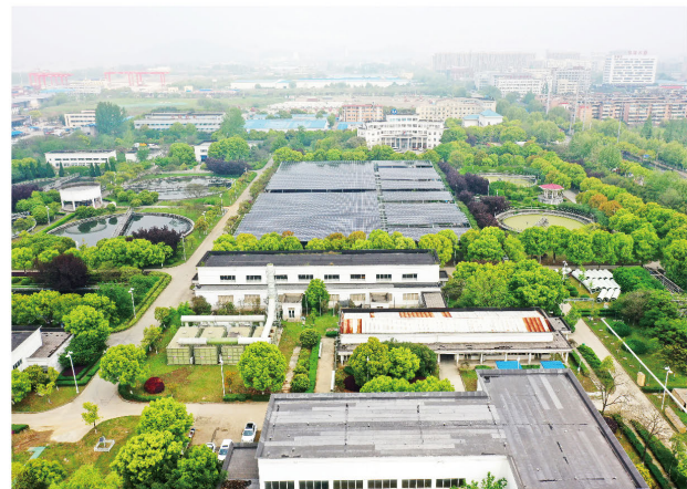
安徽芜湖朱家桥污水处理厂分布式光伏项目
