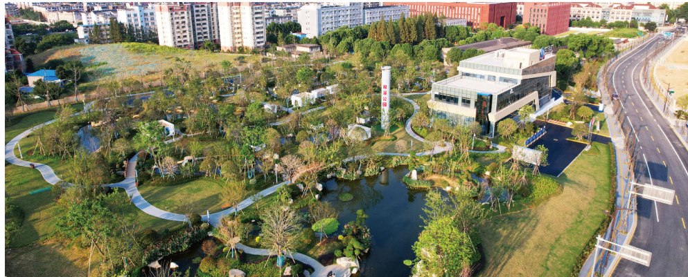
九江双溪公园（两河地下污水处理厂）
