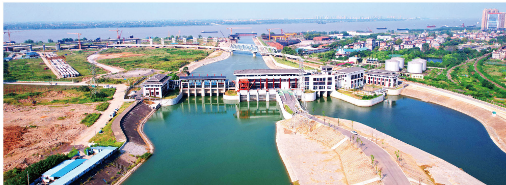
九江八赛枢纽控制工程
