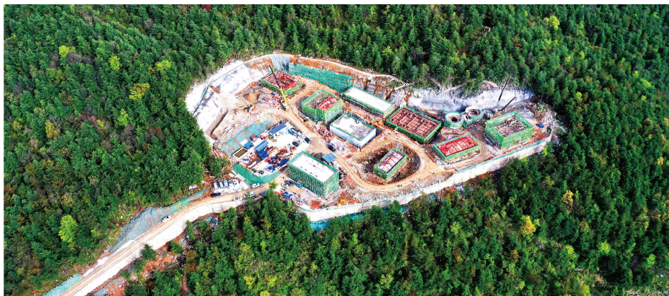
重庆巫山摩天岭综合供水工程
