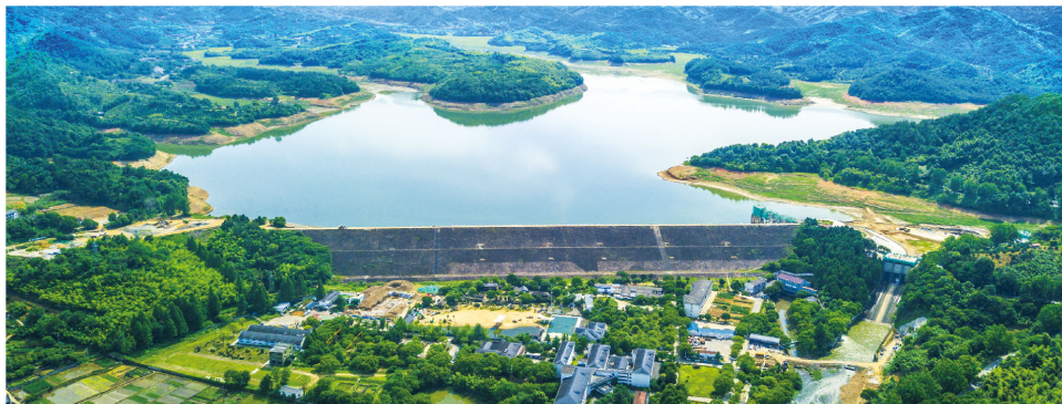
浙江诸暨陈蔡水库水源地下水资源保护项目
