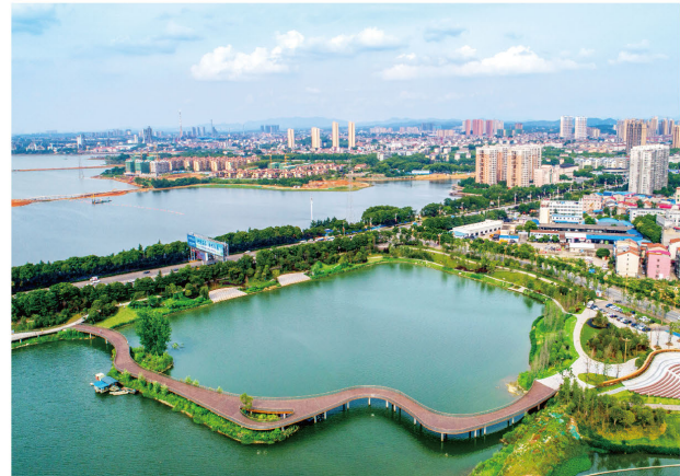
湖南岳阳东风湖水环境综合治理项目
