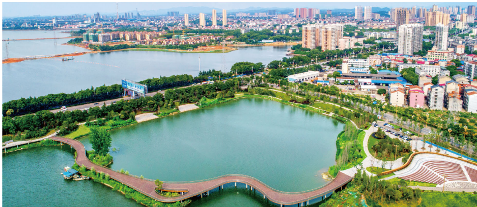
岳阳东风湖水环境综合治理项目
