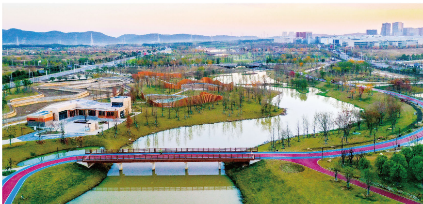
武汉光谷生态大走廊项目
