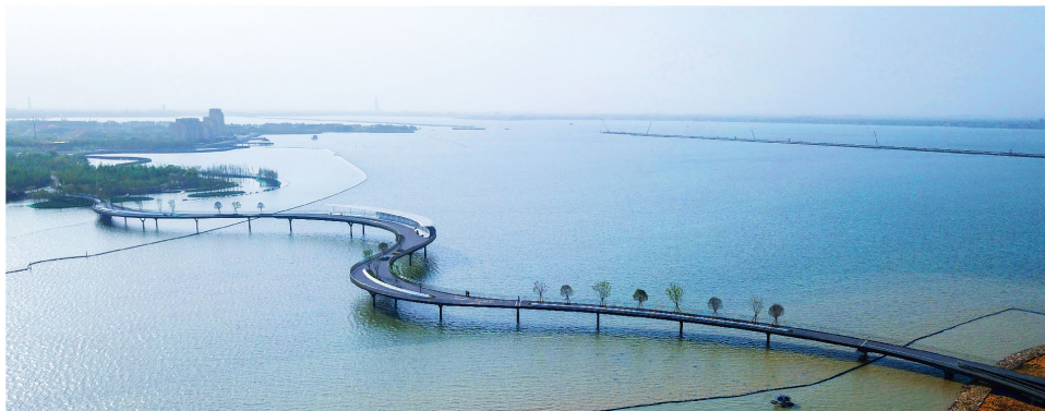
长三角一体化示范区环元荡岸线贯通工程
